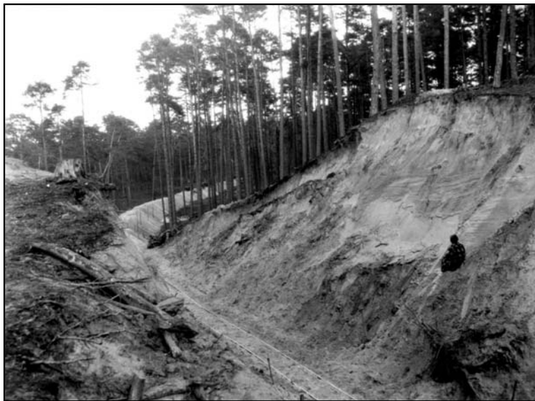
Budowa torowiska, 1930 r.
