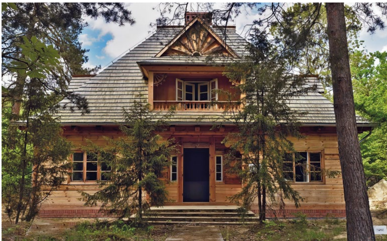
Budynek dawnego muzeum w trakcie prac rewitalizacyjnych
