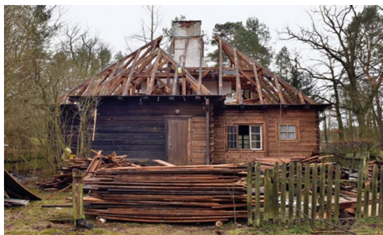
Rozbiórka budynku dawnego Muzeum, widok od strony podwórza, styczeń 2019 r.
