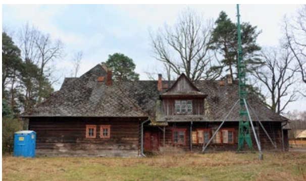
Budynek dawnego Nadleśnictwa przed remontem, stan na 2016 r.
