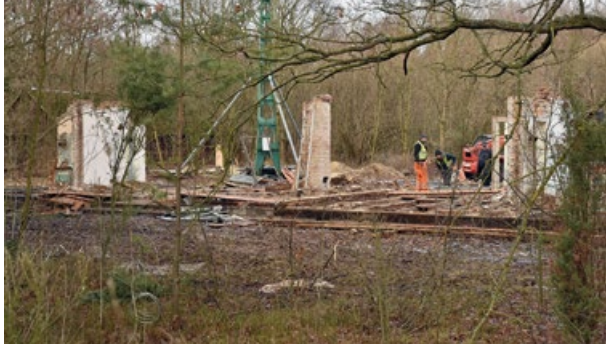
Rozbiórka budynku, styczeń 2019 r.
