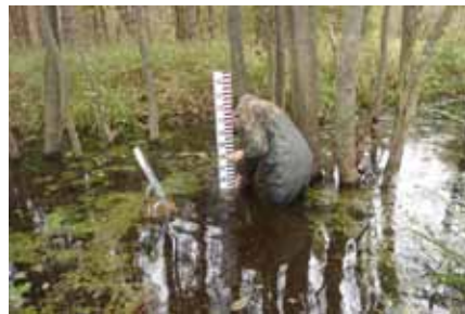
Montaż wodowskazu na Kanale Olszowieckim (AO)
