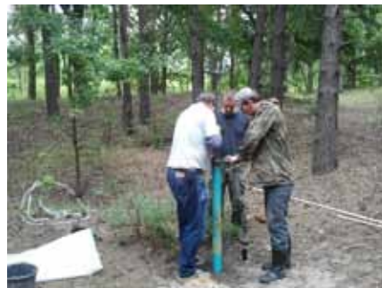
Montaż piezometru (AO)
