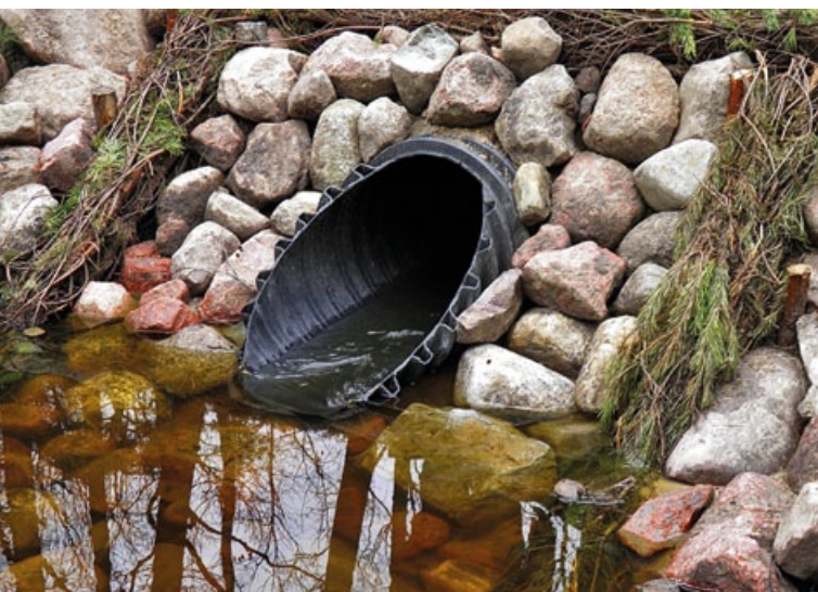
Przepust w o.o.ś. Sieraków, fot. A. Andrzejewska
