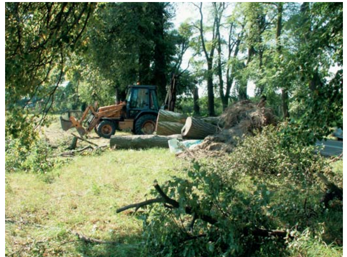
Prace konserwacyjno-porządkowe (druga połowa sierpnia 2008 r.)
