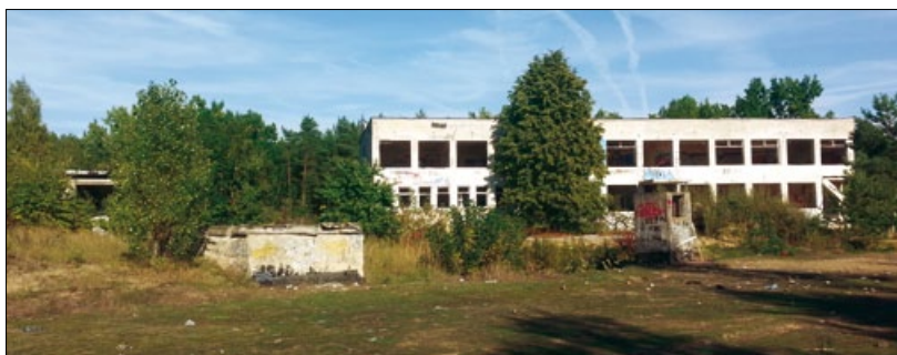
Naziemna część dawnej bazy wojskowej przeznaczona do rozbiórki, fot. P. Fidler
