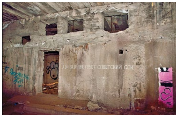
Podziemia obiektu przeznaczone do adaptacji na siedlisko dla nietoperzy, fot. M. Szajowski
