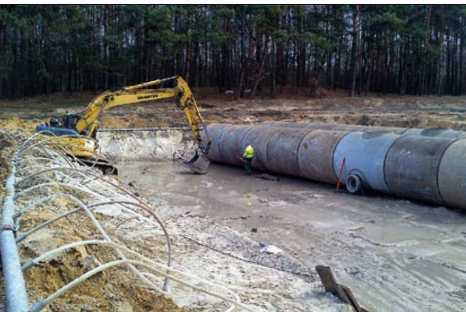
Konstrukcja parkingu / Parking lot construction fot. (KM)
